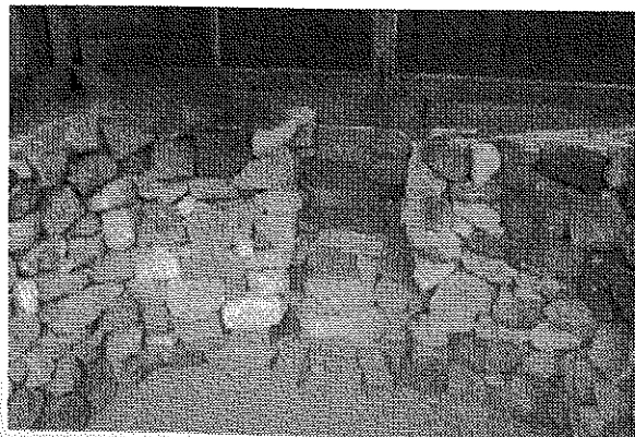
窯の奥中央にはエントツのため、耐火レンガと石でくぼみを作っておく。重要なポイント。
